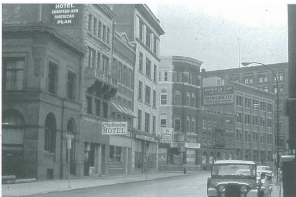
De nombreuses entreprises ont occupé ces bâtiments élégants du quartier de la Bourse au centre-ville de Winnipeg au cours du XIX e et du début du XX e siècle. Quelques années plus tard, suite à une période de régression, le quartier a fait l'objet d'une revitalisation et, en 1997, d'une désignation de lieu historique.
